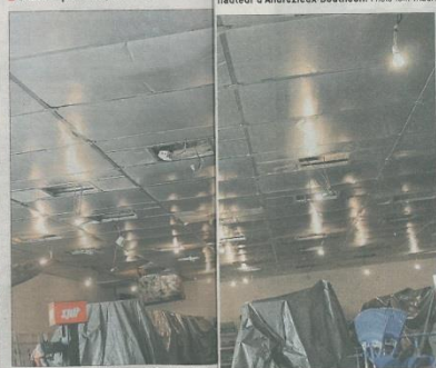
■ À Sury-le-Comtal, le faux plafond de l'enseigne Foréz Mat a été très endommagé. Photo Fabien PERAT
