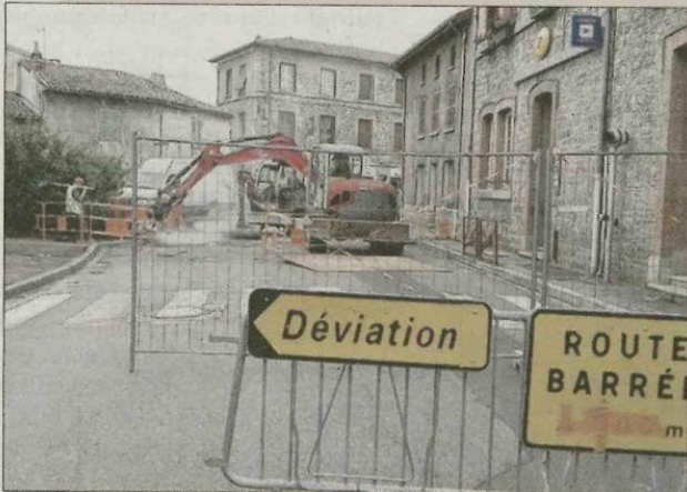
La rue Charles de Gaulle est en travaux jusqu'au 31 août. Photo Daniel DE SIMONE
