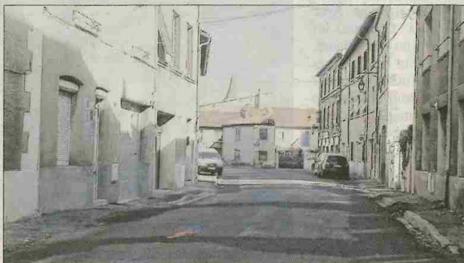
■ La rue Charles-de-Gaulle avant les travaux. Photo Daniel DE SIMONE
