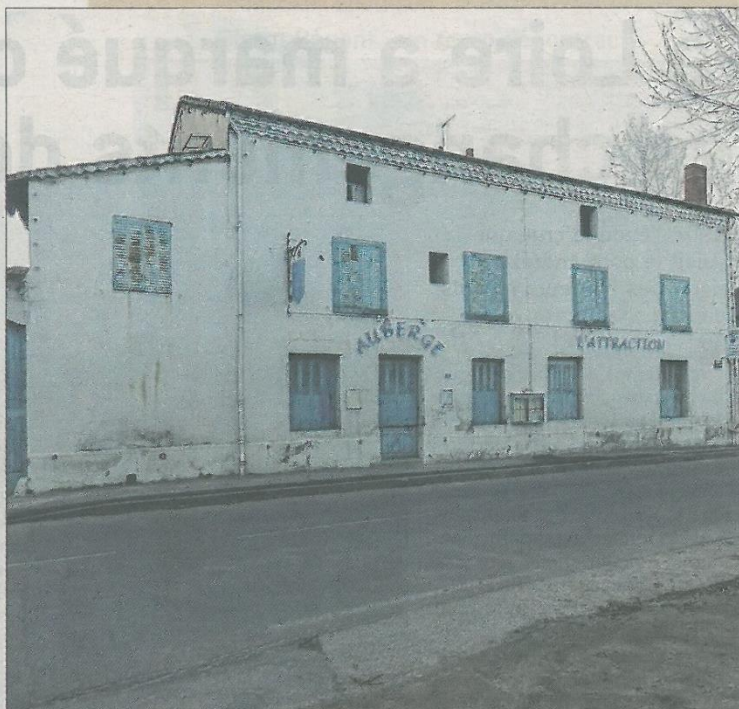
■ L'auberge de l'Attraction avant sa démolition. Photo Daniel DE SIMONE
