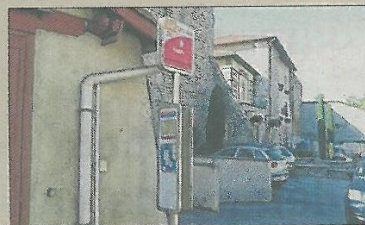
■ L'arrêt de la mairie ne sera plus desservi le temps des travaux. Photo Daniel DE SIMONE
