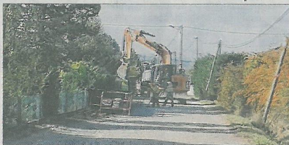
■ La canalisation de 320 mètres de long, datant de 1960, est en passe d'être changée. Photo Daniel DE SIMONE
