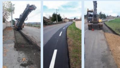
Élargissement de la voie de circulation de la RD95 route de Saint Romain avec réalisation d'un marquage des bandes de rives. Le but de l'opération étant de décaler la bande de roulement des véhicules afin de sécuriser le cheminement piéton.
