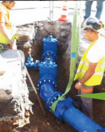
Rue Charles de Gaulle : Travaux pour le remplacement de 2 conduites d'alimentation en eau potable avec mise en place des compteurs en domaine public
