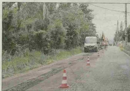
Un alternat régulé par feux tricolores permet de réguler la circulation. Photo Le Progrès/Daniel DE SIMONE
